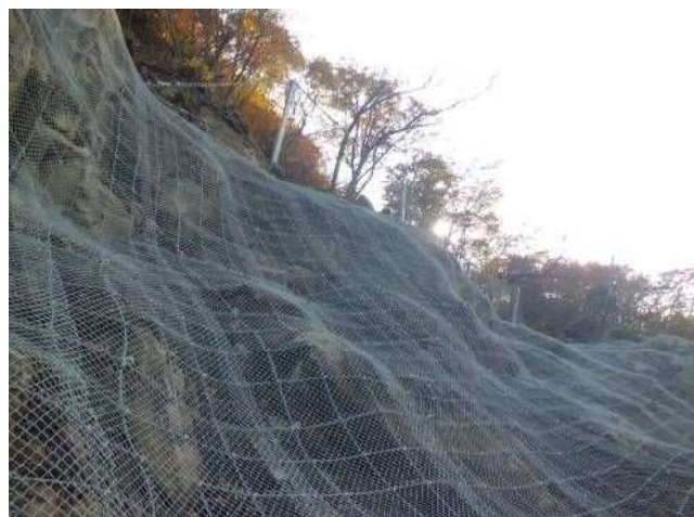
ケーブルネット工(金網あり)
