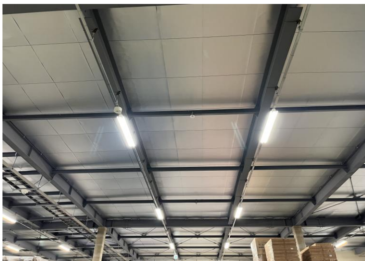
▲ 特許工法によりほとんど全ての鉄骨構造に安く早くきれいに取り付けすることができます。
