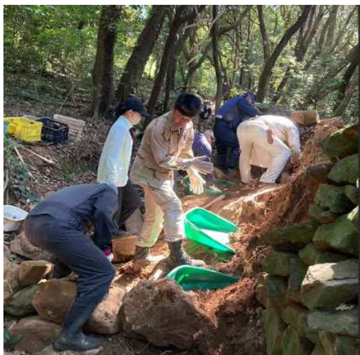
鹿垣の修復・森林整備作
