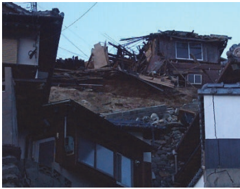
【玄界島の被害状況】
