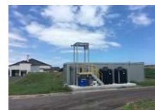
築上町有機液肥製造施設
