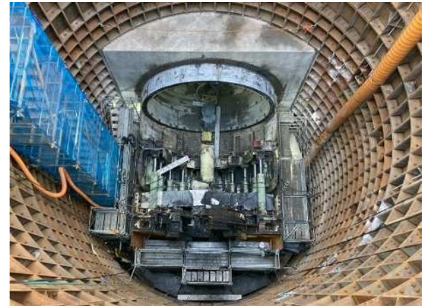
到達立坑内状況 (シールド機解体状況)
