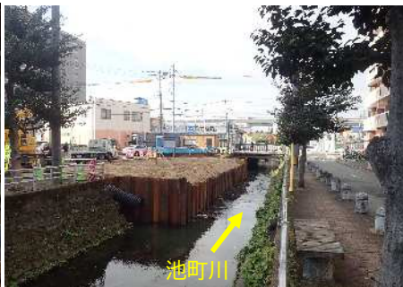
分水土の施工状況（分水土築造工事）
