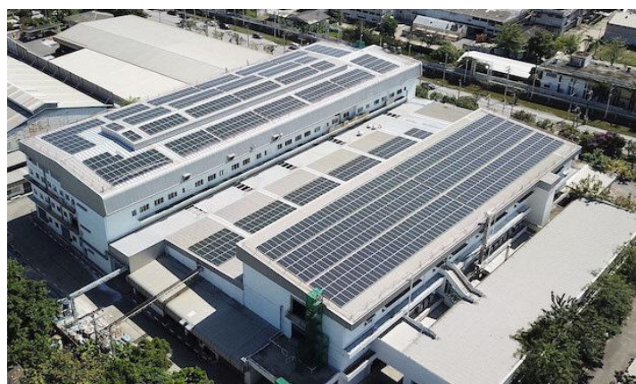
▲ 屋根置き太陽光発電所の設置例
