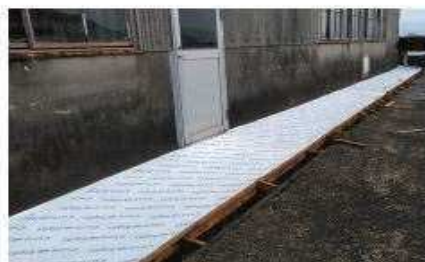
建物の犬走り
