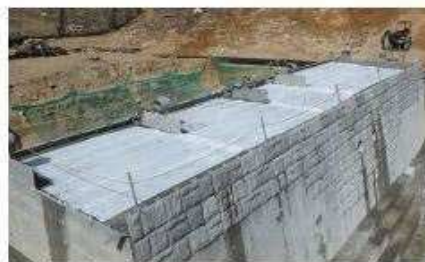
仮設養生天端
