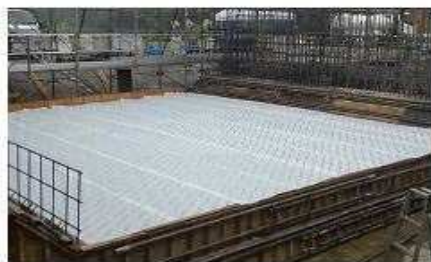
コンクリート現場打設
