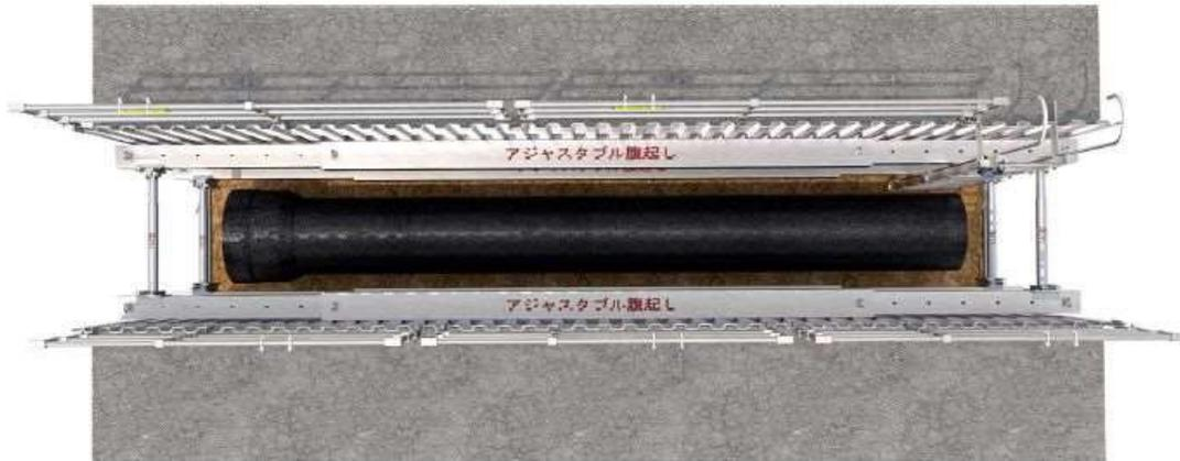
切梁間隔を広く確保できるため、長尺管を水平に吊り降ろす事が可能で、掘削工事に幅広く対応。
