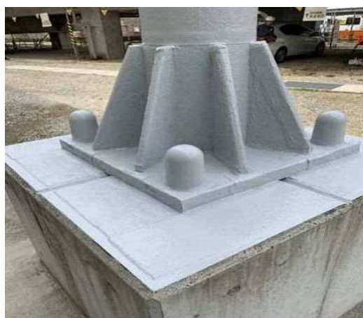
↑大阪府 支柱及び立ち上がり部
