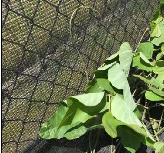
現場② 施工後3ヶ月経過
