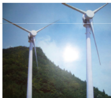
■椿ヶ原風力発電(パンフレットより)
