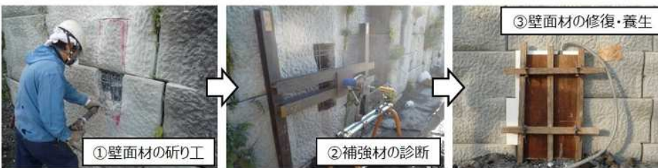
従来のアンカー補強土壁の診断作業工程
