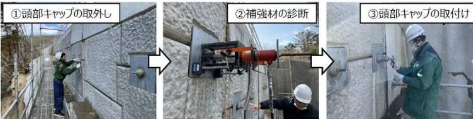
NDパネルの診断作業工程
