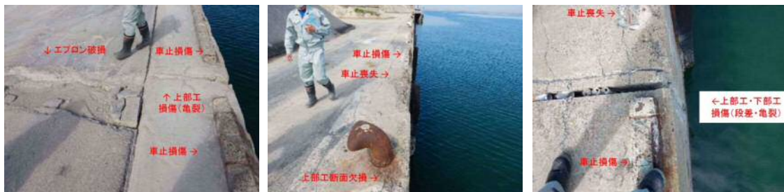
図 6.46 南港 4 号岸壁(-4.5m)の劣化状況図
