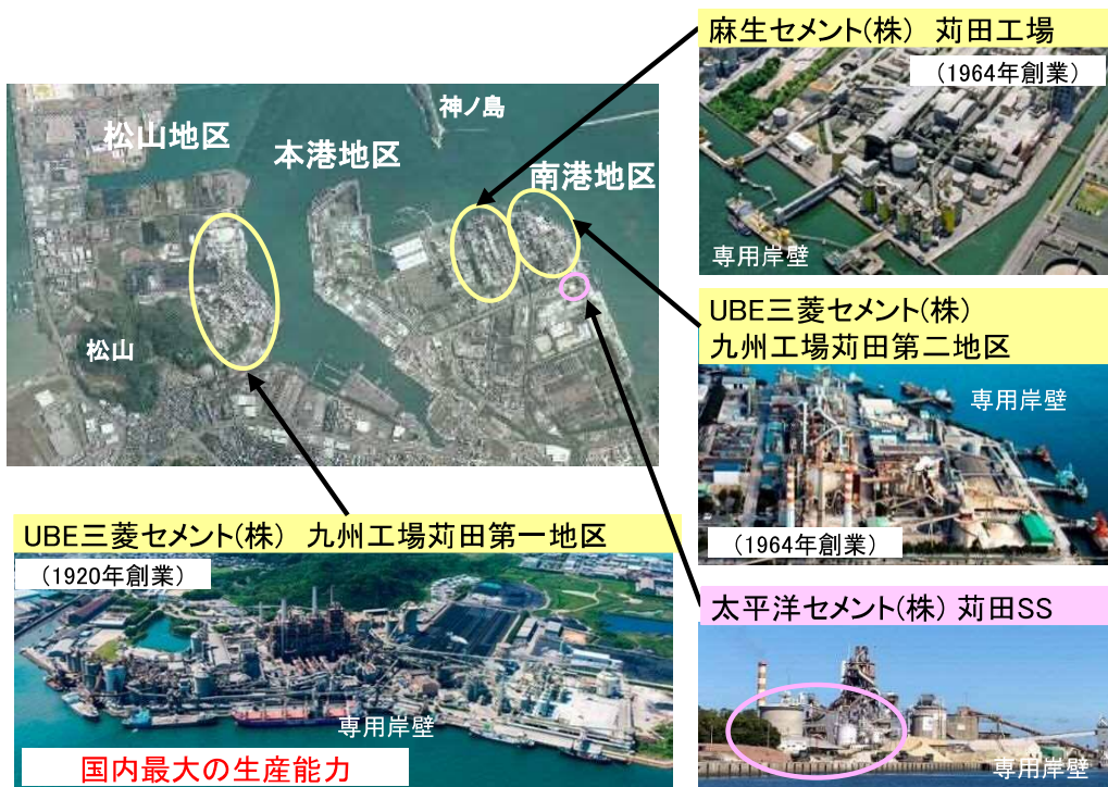
図 2.32 苅田港のセメント関連企業の状況
