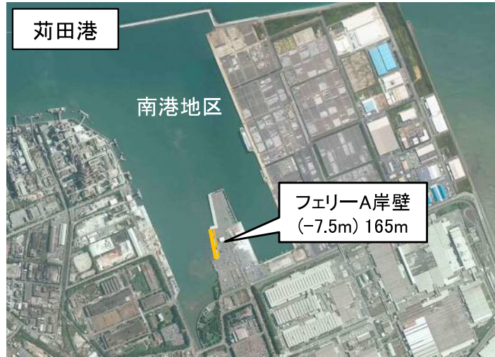
図 2.37 苅田港における RORO 船利用岸壁
