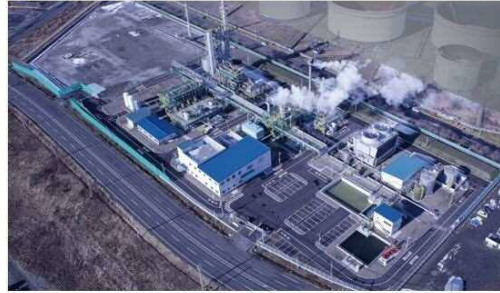
苫小牧港のCCS実証試験プラントの全景
