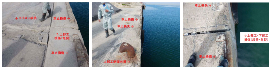
南港4号岸壁(-4.5m)の劣化状況図
