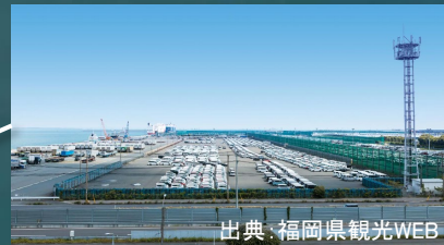
自動車積出しターミナル(耐震機能確保)
