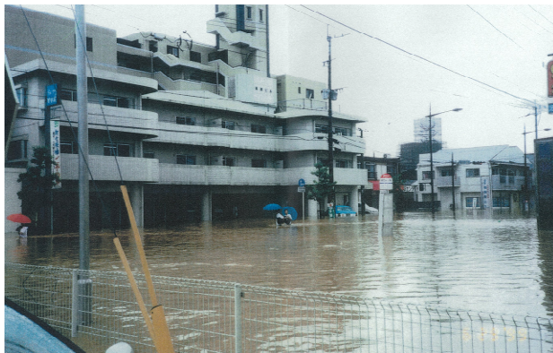
写真 2.3 釣川 田久地区付近における浸水状況（平成11年6月洪水）
