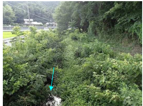
写真 1.15 長谷川【谷口橋より上流を望む】
