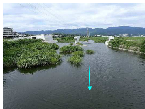
写真 1.2 多々良川【大隈橋より上流を望む】
