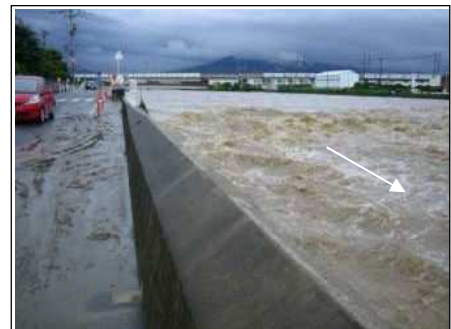
写真 2.2 平成 21 年 7 月洪水 多々良川浸水状況（多々良橋上流付近）
