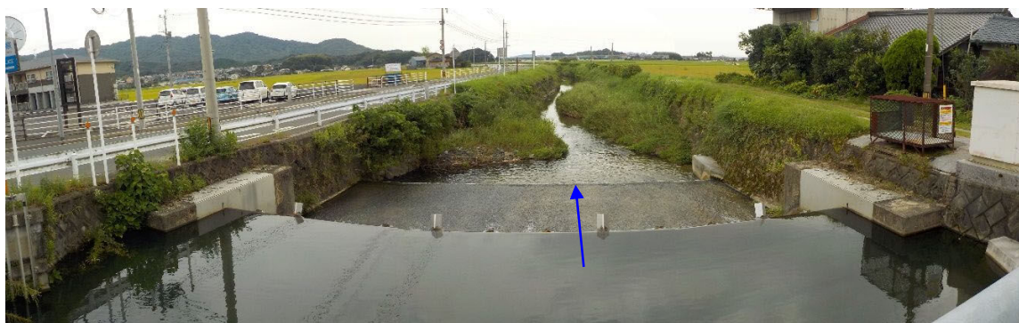
写真- 1.7 白川〔0k970、鋤崎橋下流〕
