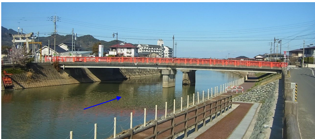
写真- 1.1 長峡川〔3k700、長音寺橋付近〕
