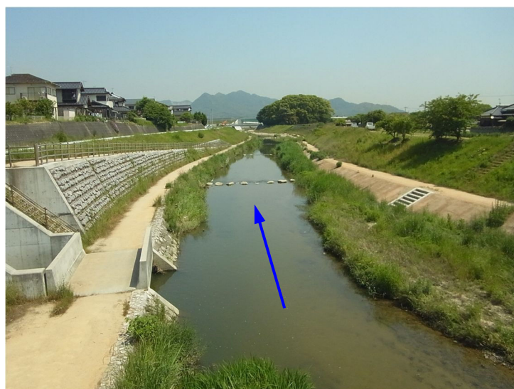
写真- 2.3 長峡川 5k300 古川橋より下流方向の様子
