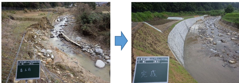
災害復旧の様子
