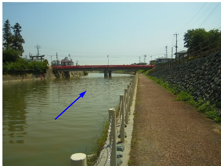
写真- 2.2 長峡川 3k700 上流側より長音寺橋付近の様子
