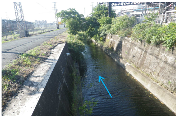
写真 1.5 1k400 工場付近
