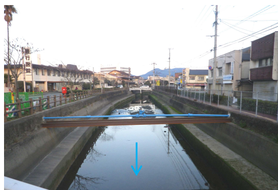
写真 1.4 旭橋上流 (0k640) 付近
