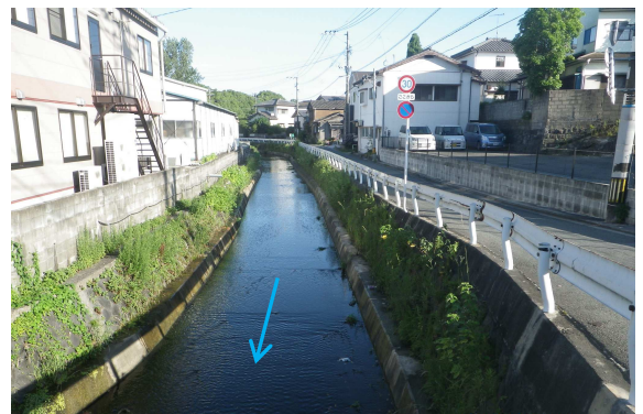
写真 1.6 市道七浦橋 (2k212) 上流付近
