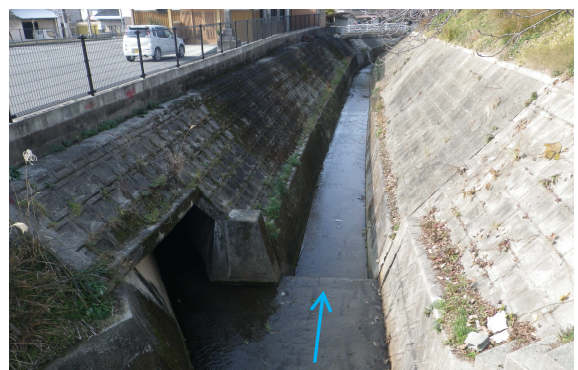
写真 1.8 ひばりヶ丘 1号橋 (4k415) 下流付近
