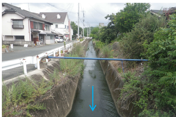
写真 1.7 勝立橋 (3k732) 上流付近
