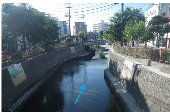
写真 1.3 栄橋下流 (0k440) 付近
