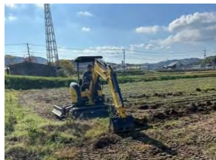
バックホウによる畦畔除去作業
