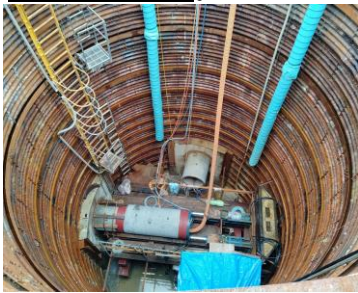
立坑内の整備状況（分水工築造工事）
