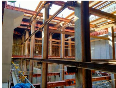
調節池内の整備状況（地下調節池築造工事）
