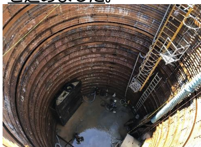
立坑内の整備状況（分水工築造工事）
