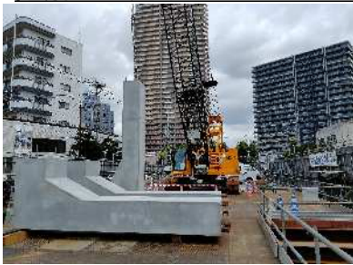
調節池部材の据付状況（地上）
