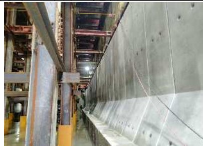
調節池部材の据付状況（地中）
