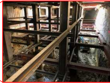
地中での作業状況
