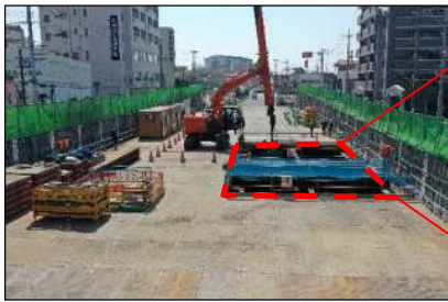
土砂掘削状況
