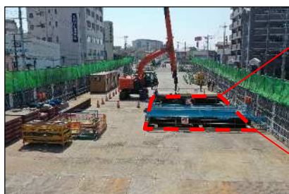
土砂掘削状況
