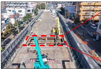
土砂掘削状況
