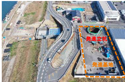
発進基地状況
