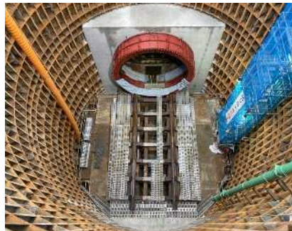
発進立坑内進捗状況 (シート・マツ組立準備工完了)
