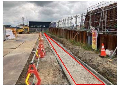
防音ハウス基礎構築状況
