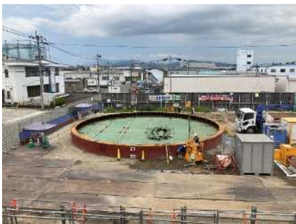
地盤改良工 全景
