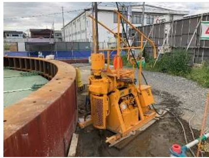
地盤改良工 近景 (ボーリングマシン)
