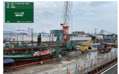
圧入掘削状況
