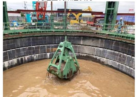
発進立坑内部 掘削状況
