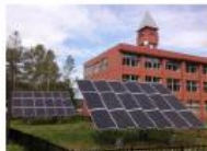
避難所に設置した太陽光発電
