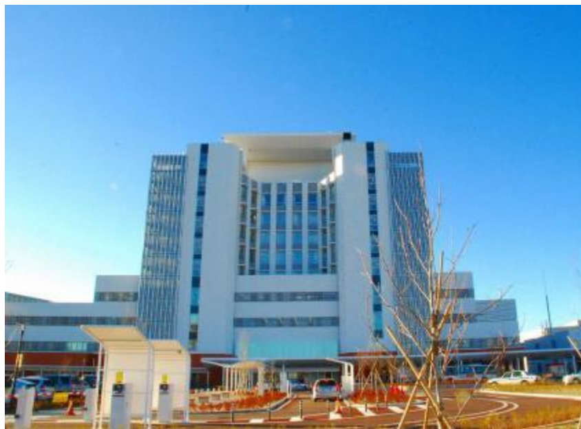
▲ 仙台市立病院外観
