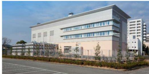
図2: 電気室を2階に整備したエネルギーセンターの全景
