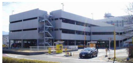
図1: 立体駐車場の全景(手前側が出口ゲート)
