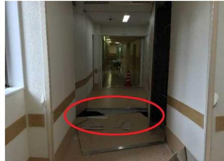
渡り廊下の被害状況（左：建物外部，右：建物内部）
