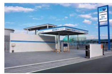
東浜水素ステーション
