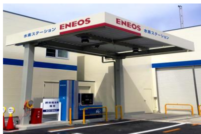
Dr. Driveセルフ福岡空港店 水素ステーション
