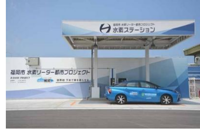
福岡市中部水処理センター 水素ステーション
