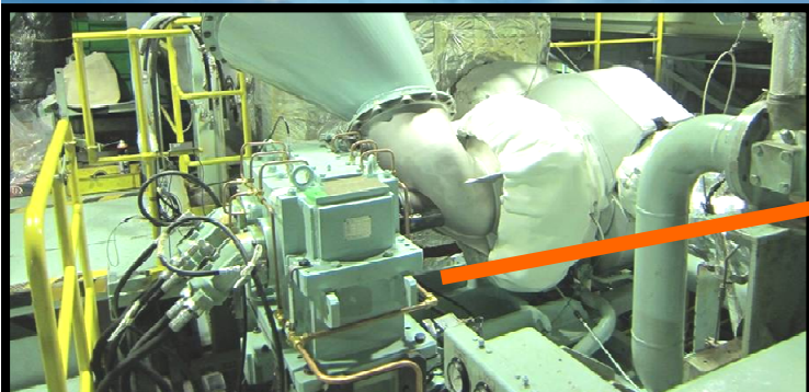
過給機側 (減速機+油圧ポンプ)
