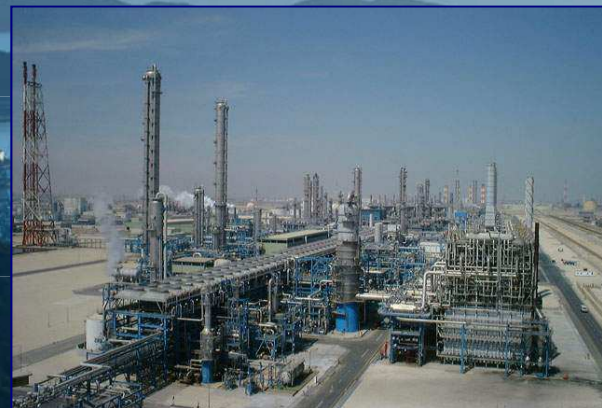
石油プラント
