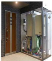
集合住宅向けエネファーム
