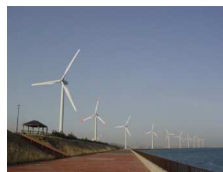
風力発電設備
