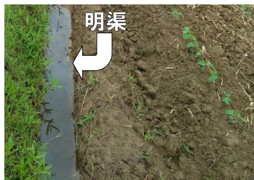
6月播きにおける明渠の施工
