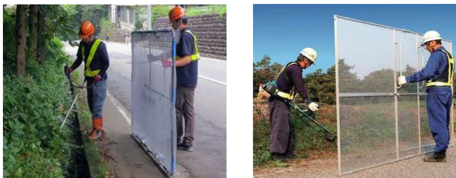
ネットによる作業例
