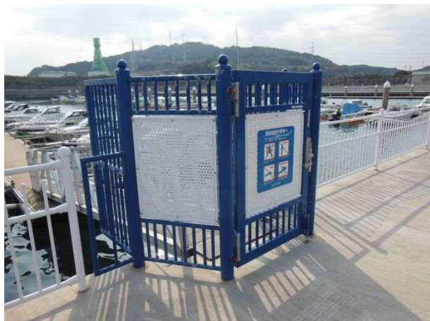
栈橋の出入口
