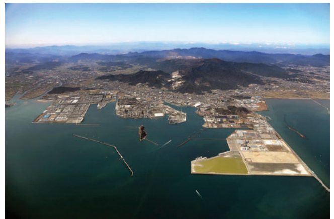
苅田港の航空写真
