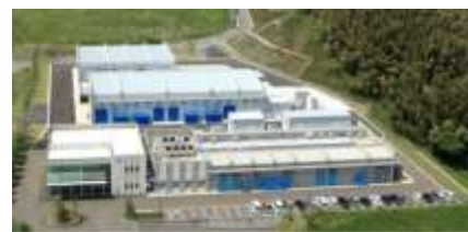
水素エネルギー製品研究試験センター (糸島市)
