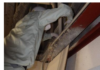
解体等工事現場への立入検査 (アスベスト対策)
