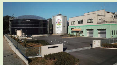
バイオマスセンター「ルフラン」 （みやま市）
