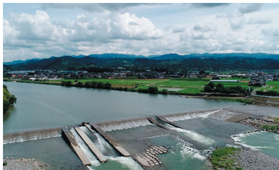
うきは市浮羽町古川 筑後川大石堰
