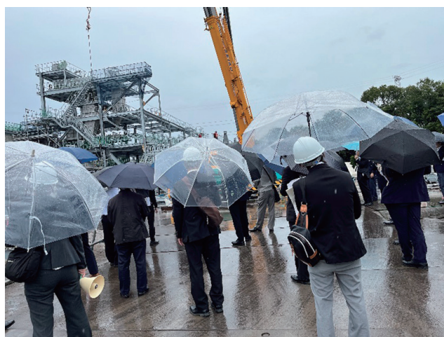
現場見学状況 大分市大在水資源再生センター
