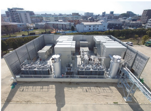
御笠川那珂川流域：御笠川浄化センター消化ガス発電施設（民設民営）
