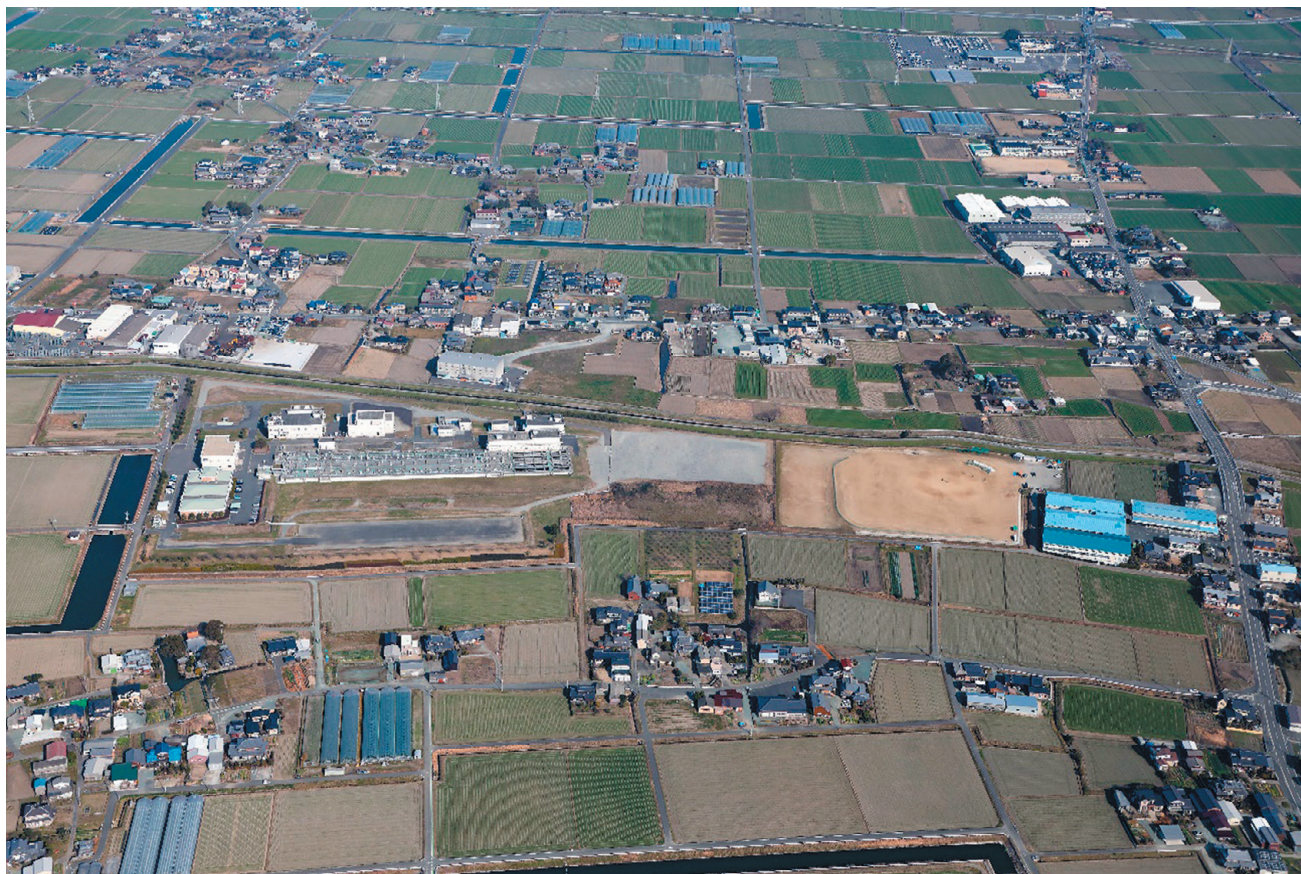
矢部川浄化センター
