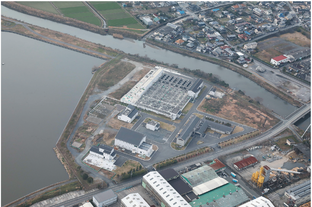
遠賀川下流浄化センター
